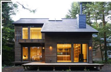
周囲の環境を活かし景観に溶け込むように佇む軽井沢南ヶ丘パッシブハウス。竣工後の気密測定で0.10 cm<sup>3</sup> / m<sup>3</sup>という驚異的な数値を測定したほか、一次エネルギーの年間消費量 120kWh / m<sup>2</sup> a 以下という基準もクリアしている。
